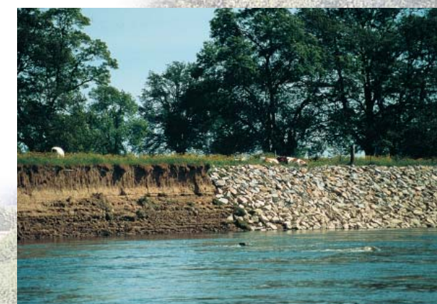
Enrochements de rive
