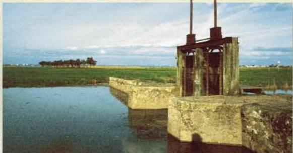
Un important réseau d'étiers et d'ouvrages hydrauliques, intensifié jusqu'au milieu du XX<sup>e</sup> siècle, a permis le drainage du marais et sa valorisation par l'élevage. Aujourd'hui ce maillage complexe est géré par des syndicats de marais.
